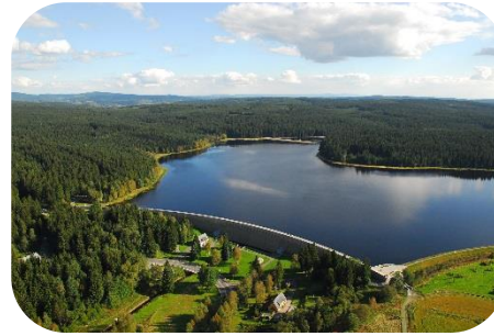
z.B. Trinkwassertalsperre Muldenberg
